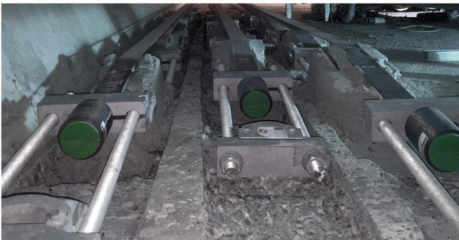
Abb. 04: Gespannte StressHead-CarboStress® Systeme
