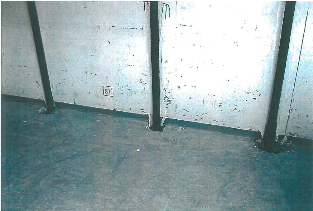
Die Lösung mit vertikal angeordneten, vorgespannten CFK-Lamellen stellte sich als optimal heraus. Im Bild die Ansicht der Gabelwand mit CFK-Lamellen.
