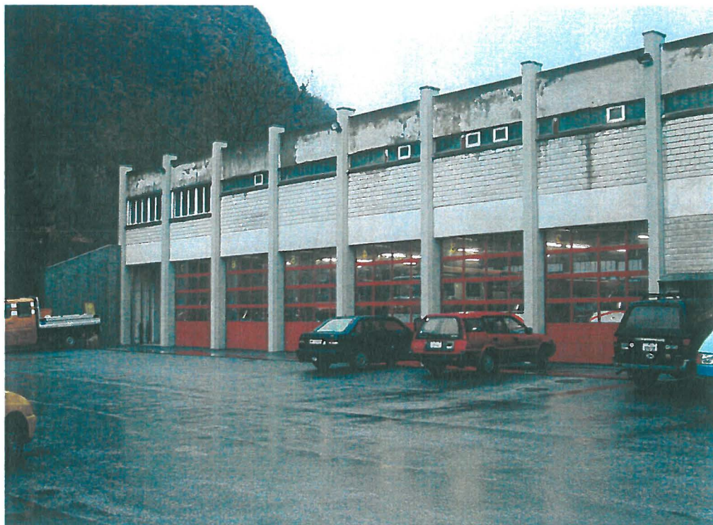
Das Gebäude der Feuerwehr Visp wurde nachträglich erdbebensicher umgerüstet.
