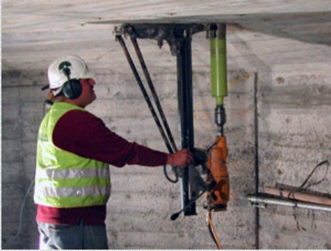
Etape 1: Carottage pour les ancrages
