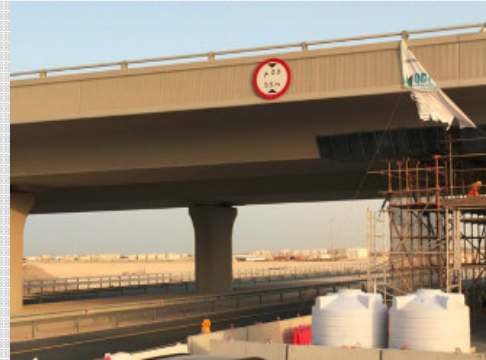
Renforcement des poutres transversales Pont N29, Qatar
