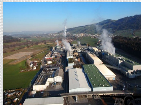
Renforcement statique Usine à papier de Perlen, Suisse
