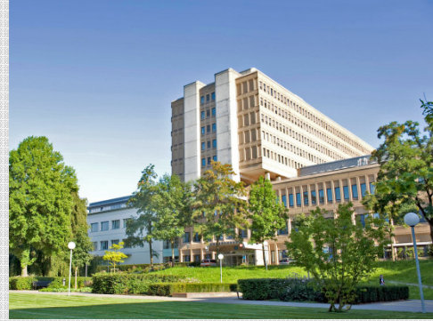
Renforcement antisismique Hôpital cantonal d'Aarau, Suisse
