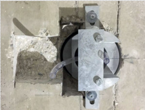
Etape 2: Montage des ancrages fixes et mobiles
