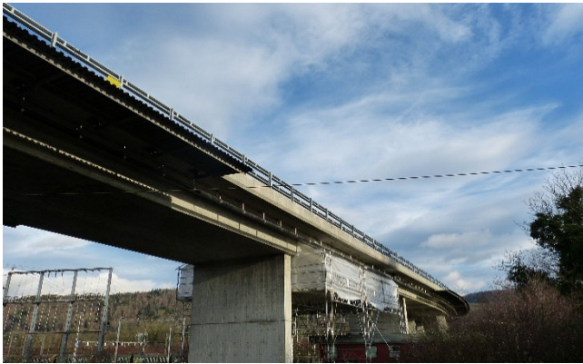
Renforcement de ponts
