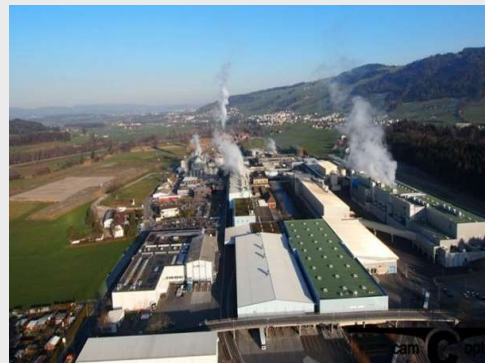
Bauwerksverstärkung Papierfabrik Perlen, Schweiz
