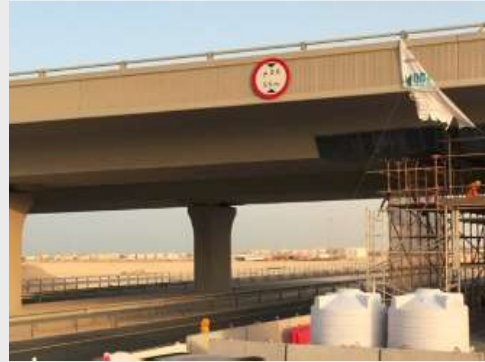
Brückenverstärkung Bridge N29, Katar
