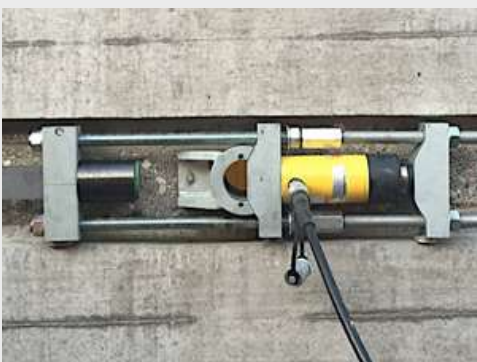
Schritt 4: Spannen des Spannglieds
