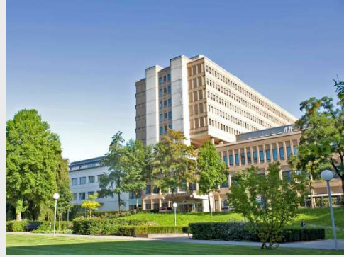
Erdbebenertüchtigung Kantonsspital Aarau, Schweiz
