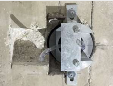
Schritt 2: Montieren der Verankerungen
