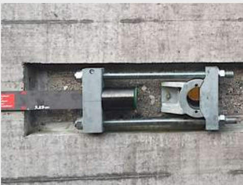
Schritt 3: Spannglied in Verankerung einhängen
