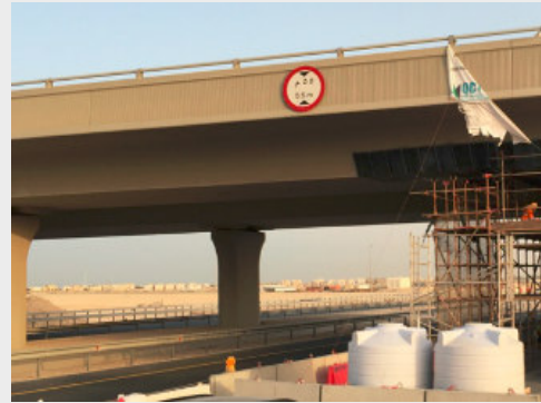
Refuerzo de puente Puente N29, Catar
