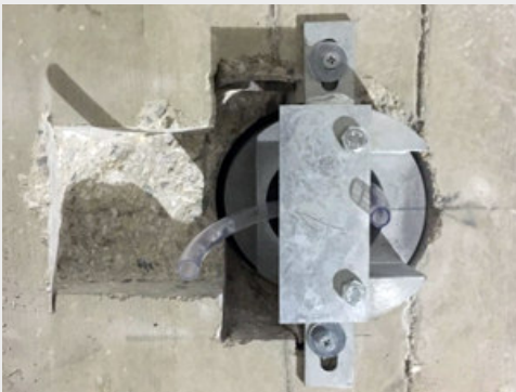
Paso 2: Colocación de los anclajes
