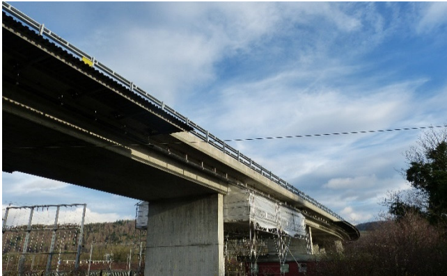
Refuerzo de puentes
