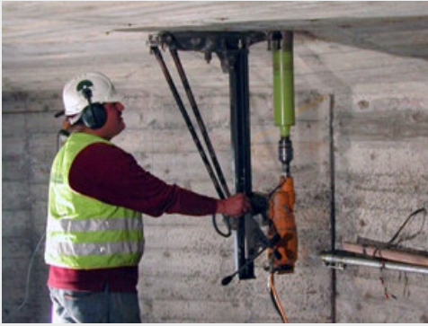
Paso 1: Perforación para los anclajes
