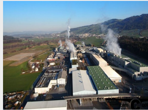
Refuerzo de viga Fábrica de papel "Perlen", Suiza
