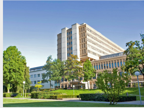
Refuerzo sísmico Hospital Aarau, Suiza
